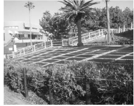
道路法面に設置した薄膜太陽電池
