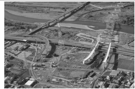
建設中の新東名高速道路
