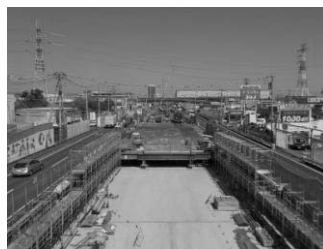
国道129号（戸田立体）の整備
