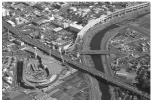
高速横浜環状北線 港北JCT
