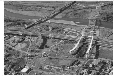
建設中の新東名高速道路
