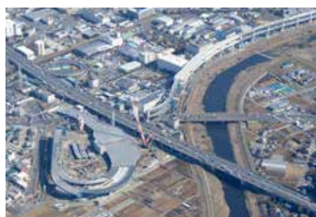
高速横浜環状北線 港北JCT
