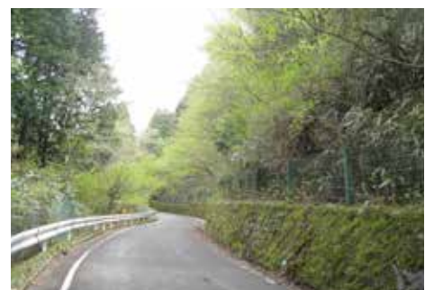
南足柄市と箱根町を連絡する道路の整備
