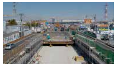
国道129号(戸田立体)の整備
