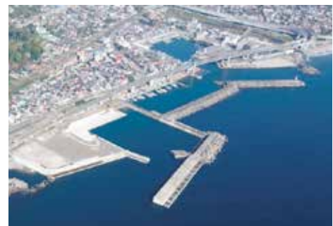
整備が進む小田原漁港
