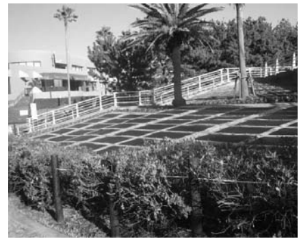
道路法面に設置した薄膜太陽電池
