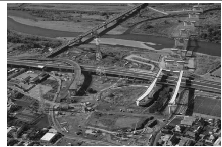
建設中の新東名高速道路
