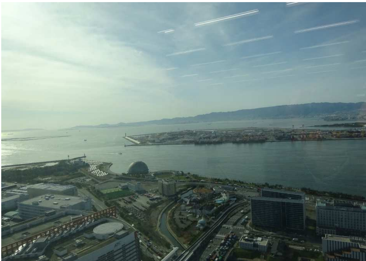
万博建設現場（対岸の人工島夢洲の一部）
