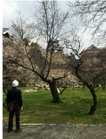
(至るところで崩壊した熊本城の石垣)
