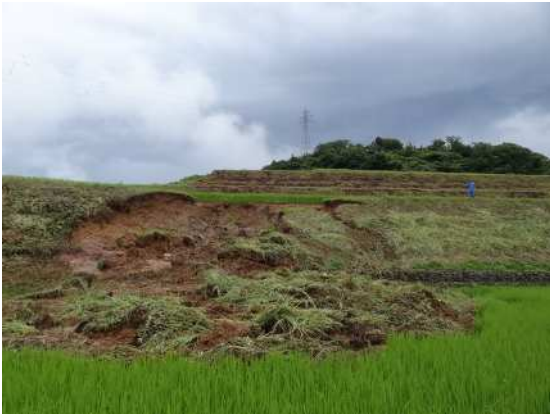
【豪雨による斜面崩落箇所】
