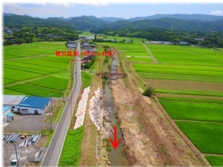
④ 被災箇所を下流より望む
