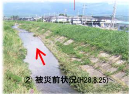
① 被災箇所を上流より望む
