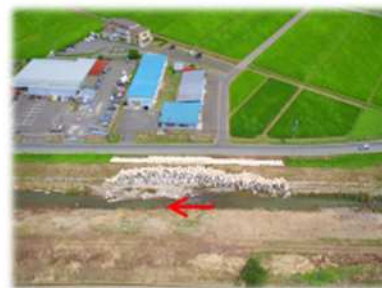
⑤ 応急仮工事状況(川表)
