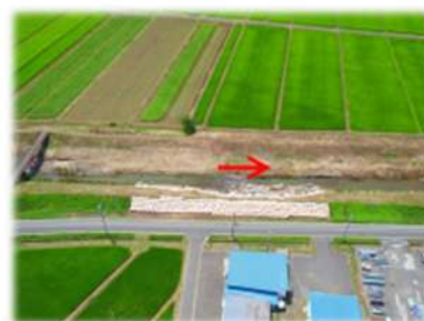
⑥ 応急仮工事状況(川裏)
