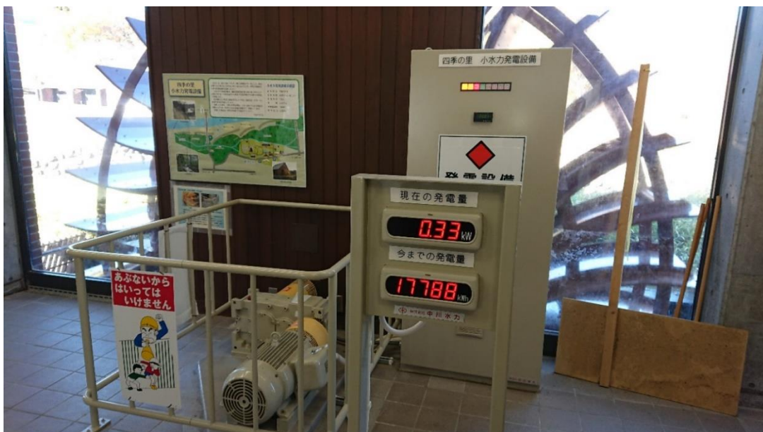
小水力発電の内部の様子。現在の発電量などが表示されている。 外側に水車がみえる。
