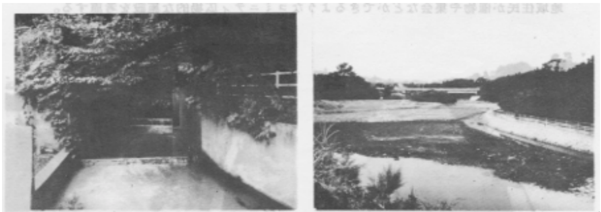
生活系排水の河川流入例(大和市上草柳地内)
