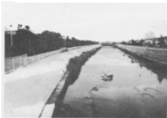
カミソリ護岸(藤沢市辻堂太平台地内)
