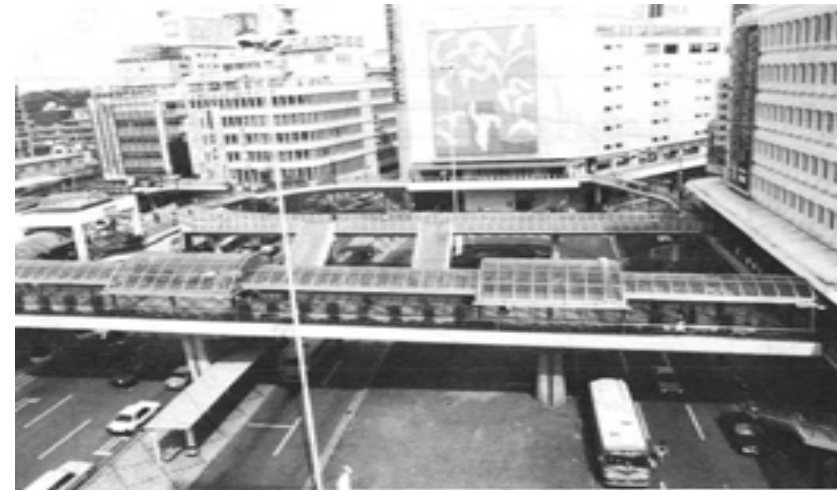
藤沢駅南口状況
