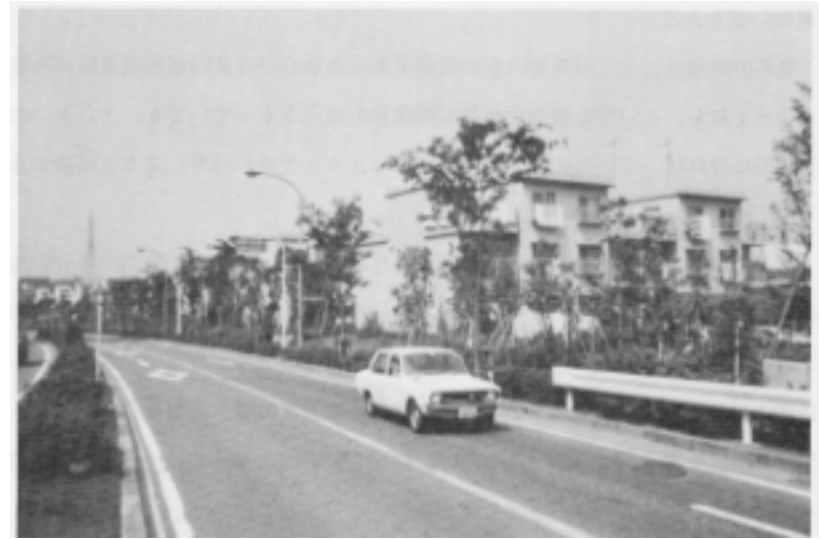
▲ 電線・電柱のない街並み（横浜市戸塚区）
