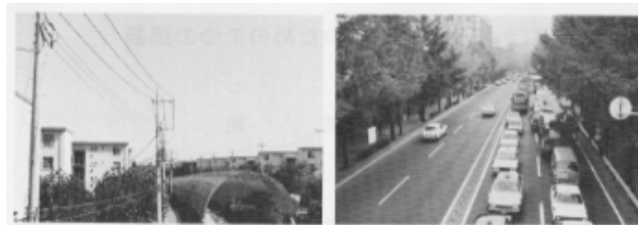
▲ 団地内を走る道路に設けられた防音壁
