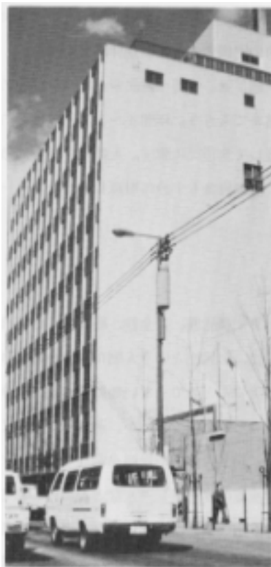
▲電柱をデザイン化した例 トランスをタテ型にし、垂直方向に配線、色も焦茶色にした
