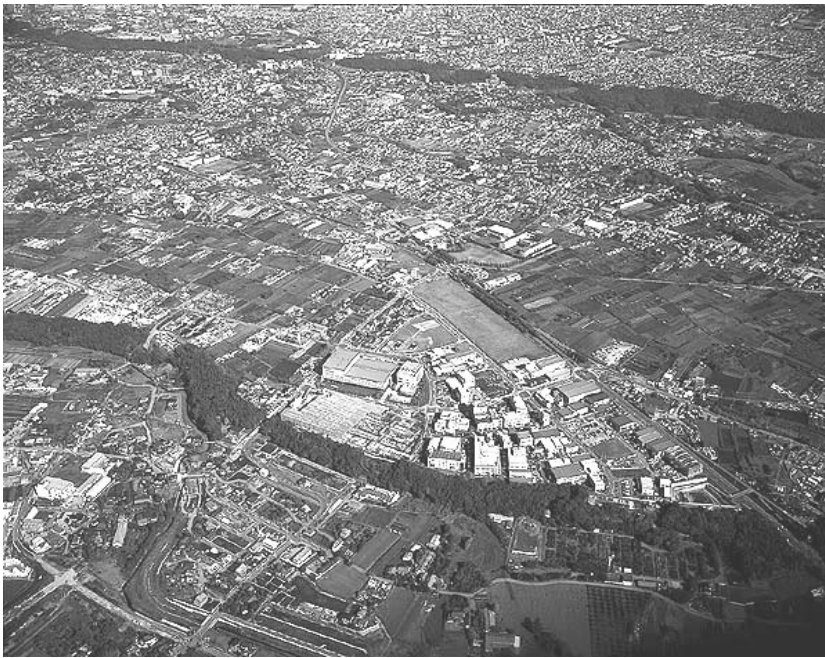
図2 住宅、工業用地、農地などが混在（相模原市付近 出典：相模原市ホームページ）
