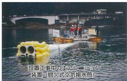
設置工事中のエアレーション装置（間欠式空気揚水筒）
