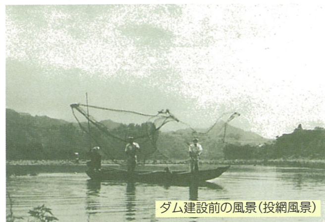
ダム建設前の相模川
