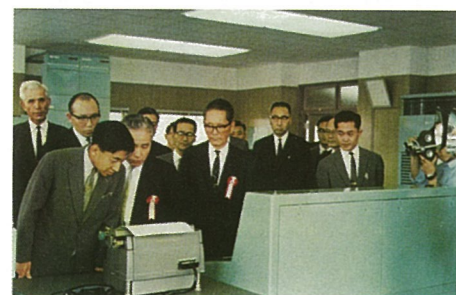
城山発電所及び城山ダム完成後は、皇太子殿下(現在の陛下)もご視察されました。
