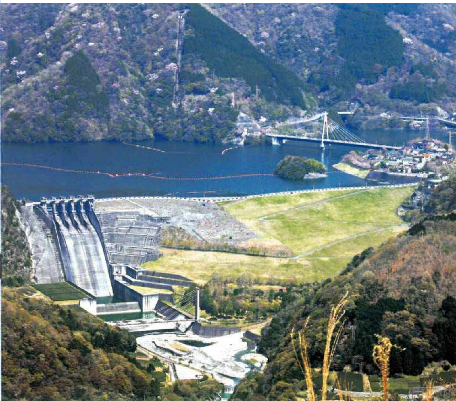
下流側から見た三保ダム
