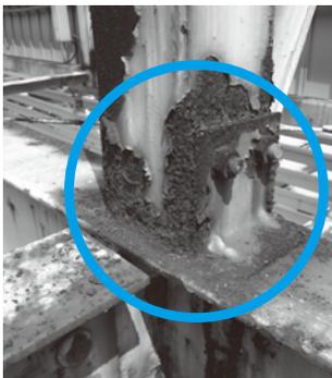
鉄骨やボルトが錆びて腐食していないかを定期的に点検。
