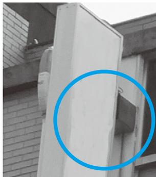
外壁などにサビ汁の跡がないか。内部の腐食が疑われます。
