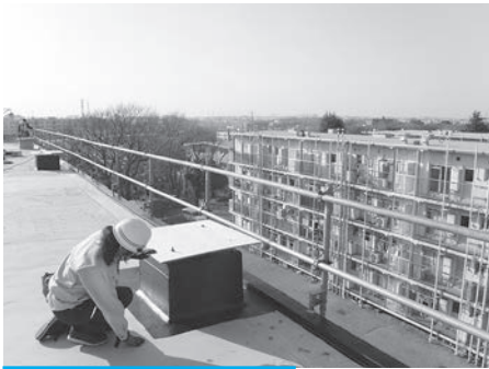
屋上防水工事
