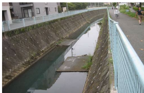
栄橋より上流をのぞむ
