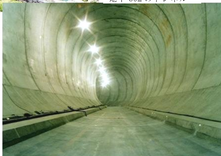
地下 50m のトンネル
