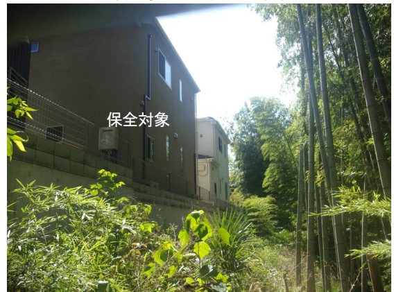
斜面状況・保全対象
