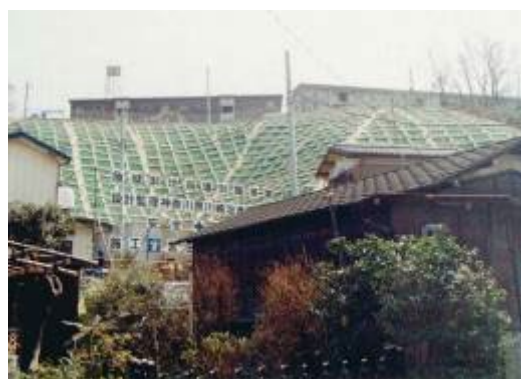
崩壊防止工事实施後
