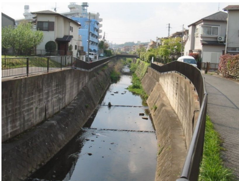
川内橋より上流をのぞむ
