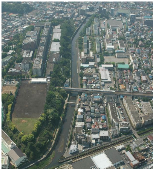
渋川合流点より上流をのぞむ
