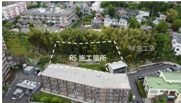
斜面状況・保全対象
