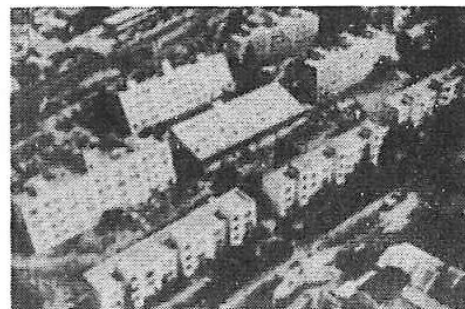
壁式構造の新潟県営住宅の傾斜(新潟地震, 新潟市川岸町)。上部構造部分は亀裂などの損傷のないまま傾斜している。基礎は直接基礎。
