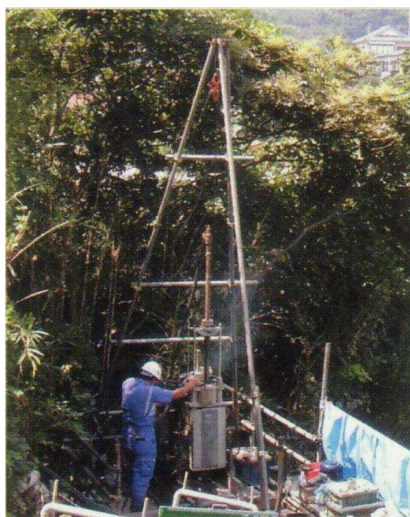
図 1-2-5 ボーリング調査の作業状況
