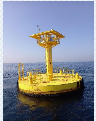
図24 新しく設置された浮魚礁
