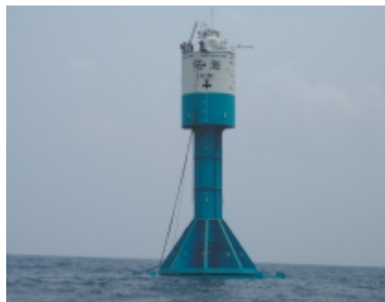
海洋深層水肥沃化装置－拓海外観
