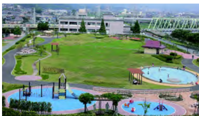
上部利用広場 (酒匂川流域下水道 扇町水再生センター)
