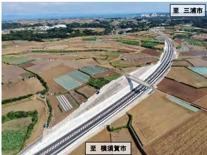
三浦縦貫道路Ⅱ期北側区間
