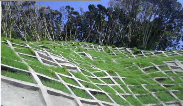
緑化による法面保護
