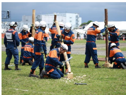
<洗掘防止工法（木流し工、シート張り工、T型マット張り工）>
