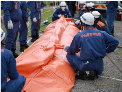
<越水防止工法（水マット工、大型土のう積み工）>
