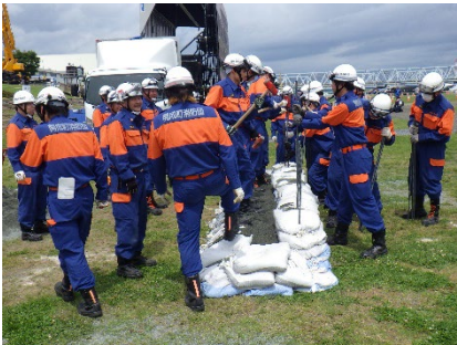
<越水防止工法（水マット工、大型土のう積み工）>
