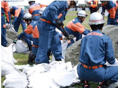
<準備工（杭拵え工、大型土のう拵え工）>
