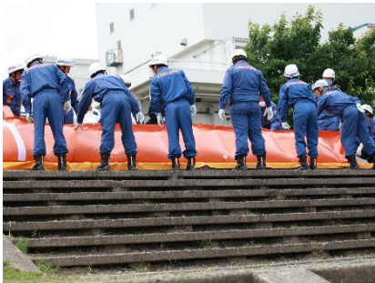
<越水防止工法（水マット工、大型土のう積み工）>
