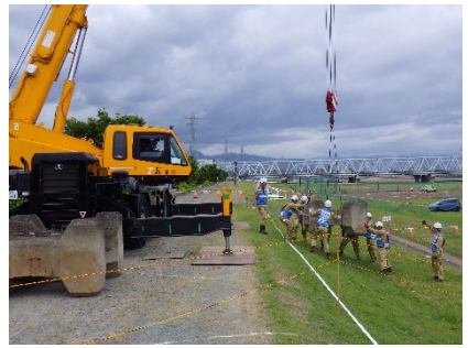
<決壊防止工法（根固めブロック工）>
