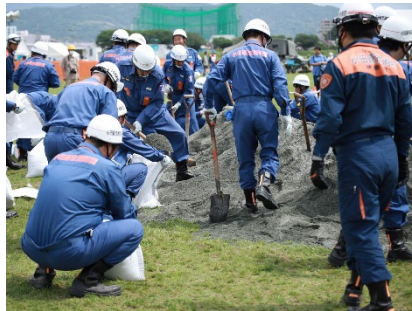
<準備工（杭拵え工、大型土のう拵え工）>
