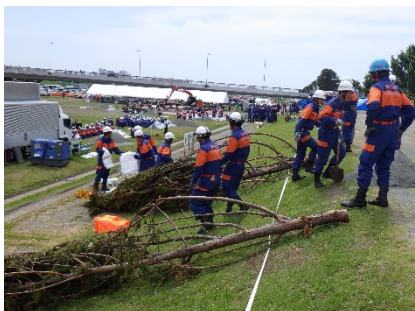
<洗掘防止工法（木流し工、シート張り工、T型マット張り工）>
