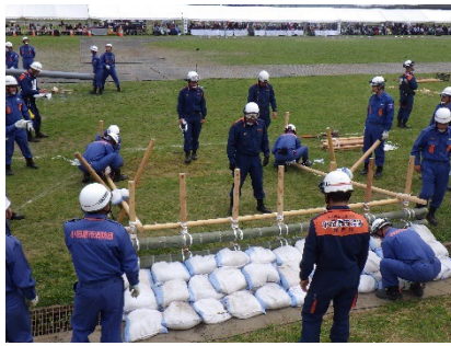
<越水防止工法（積み土のう工、鋼板積み土のう工）>
