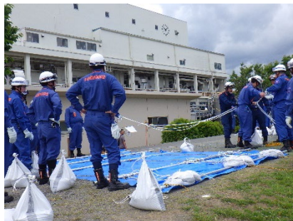
<洗掘防止工法（木流し工、シート張り工、T型マット張り工）>
