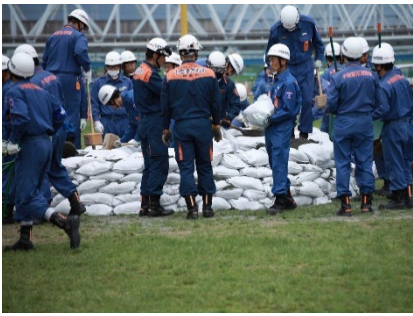
<越水防止工法（積み土のう工、鋼板積み土のう工）>
