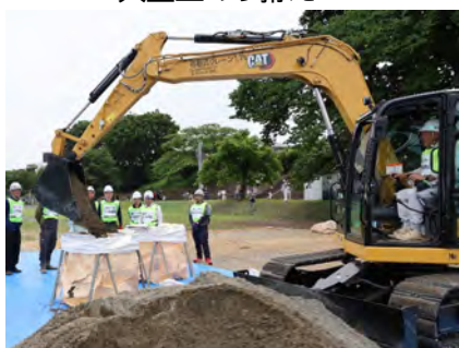
積み土のう工と同様に、洪水によって堤防が沈下した場合や水が堤防を越える恐れがあるときに用いる工法。大規模な越水対策として有効
