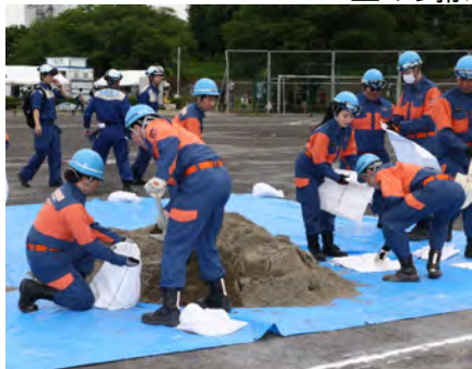
積み土のう工やシート張り工等、様々な水防工法に用いる土のうを製作する工法
