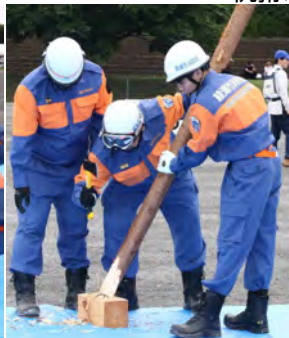
シート張り工やT型マット張り工等、 様々な水防工法に用いる杭を製作する工法
