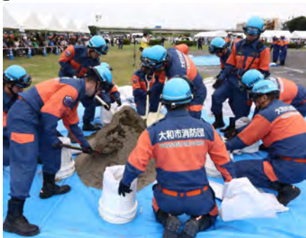
積み土のう工やシート張り工等、様々な水防工法に用いる土のうを製作する工法
