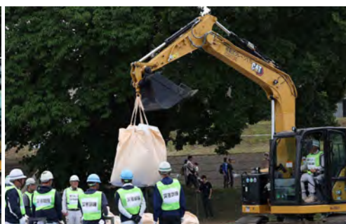
積み土のう工と同様に、洪水によって堤防が沈下した場合や水が堤防を越える恐れがあるときに用いる工法。大規模な越水対策として有効
