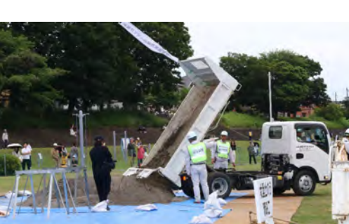
積み土のう工と同様に、洪水によって堤防が沈下した場合や水が堤防を越える恐れがあるときに用いる工法。大規模な越水対策として有効
