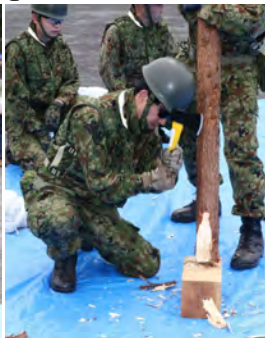
シート張り工やT型マット張り工等、 様々な水防工法に用いる杭を製作する工法
