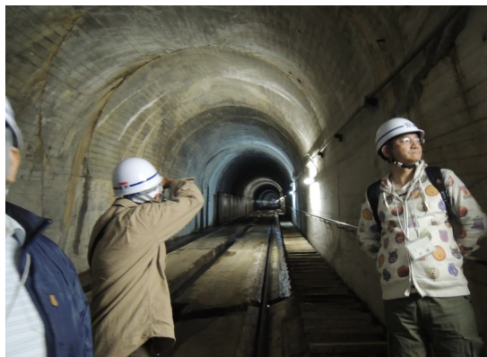
城山発電所インクライン
