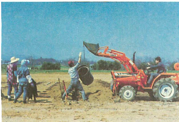
写真2 土管の埋設
