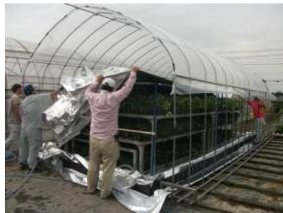
図9-2 処理装置設置作業
