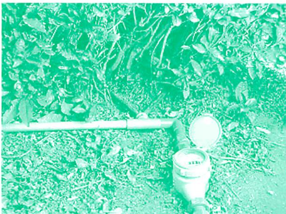
茶株元に取り付けられた配水管と灌水チューブ
