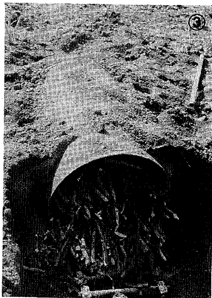
第1図 簡易ドラム缶がまによる製炭
