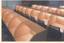
秦野高校 自習室改修工事
