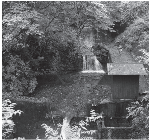
写真3 大洞沢の出水後の量水堰 No.1
