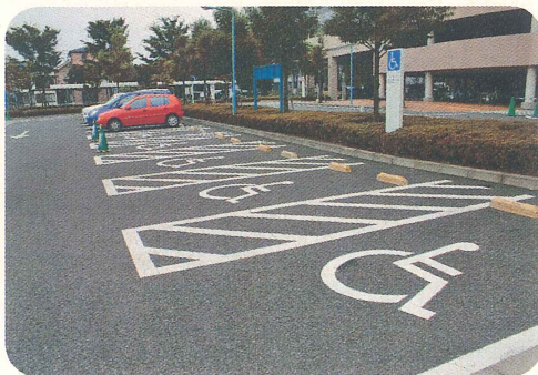
車いす使用者用駐車区画
