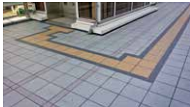
コントラストのある誘導ブロック（良い例）
