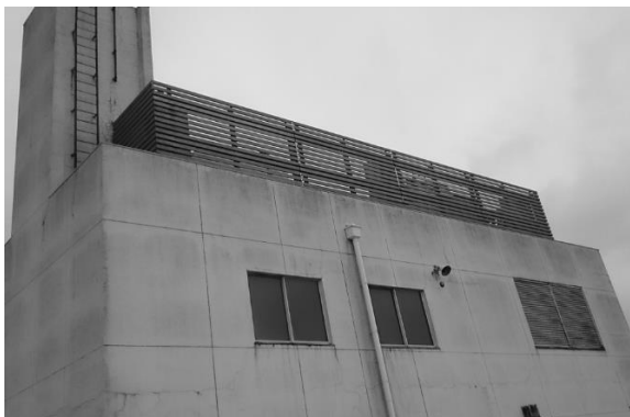
写真7 新館屋上塔屋
