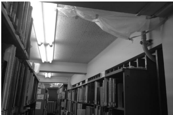
写真5 4階社史室の天井
