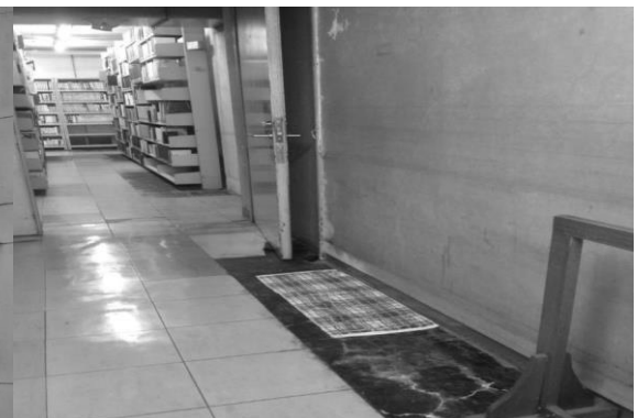
写真 6 新館東側書庫
