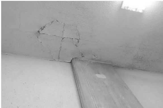
写真3 3階科学技術室天井
