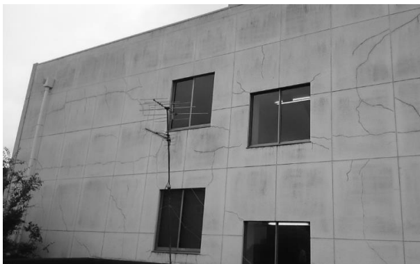
写真 5 新館東側外壁
