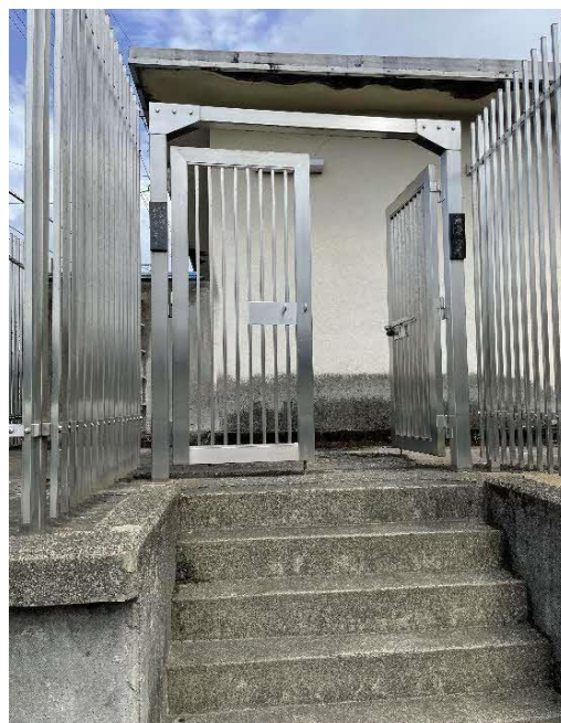
34 飯山揚水ポンプ所用地
