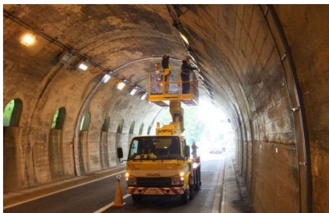
写真-解 6.1 近接目視作業状況
