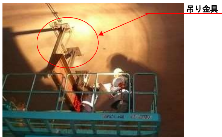
写真-解 6.3 触診作業状況
