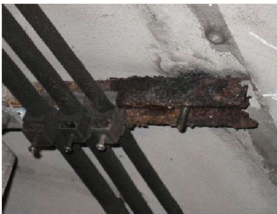
付写真-1.13 固定金具の腐食とアンカーボルトの脱落の例
