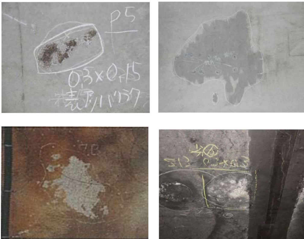
付写真-1.6 覆工コンクリートが変色している例 (うき・はく離を伴う)
