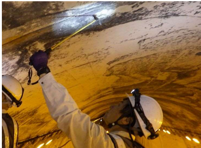
(a) トンネル本体工
