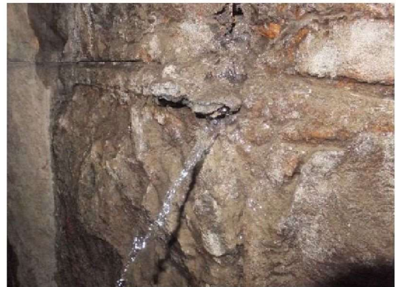
付写真-1.7 漏水（噴出）している例
