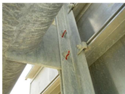
標識板取付部
