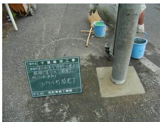
写真-解 12-1 水切りコンクリートの施工事例
