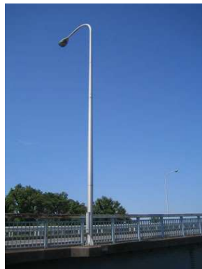
橋梁部に設置
