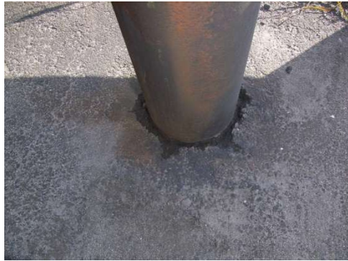
腐食、路面付近での滞水
