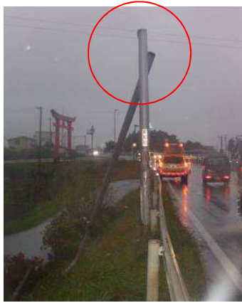
写真-解 8-8 支柱継手部の折損状況
