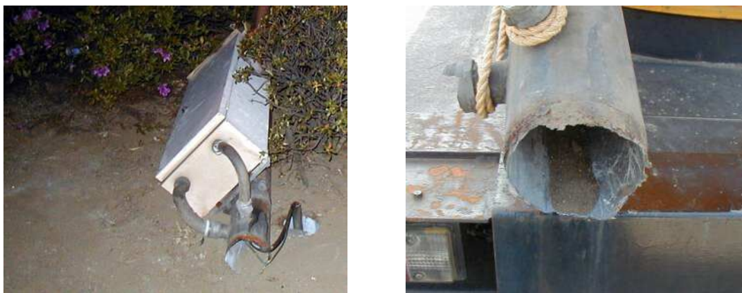
写真－2. 1 路面境界部の腐食が要因となった倒壊事例
