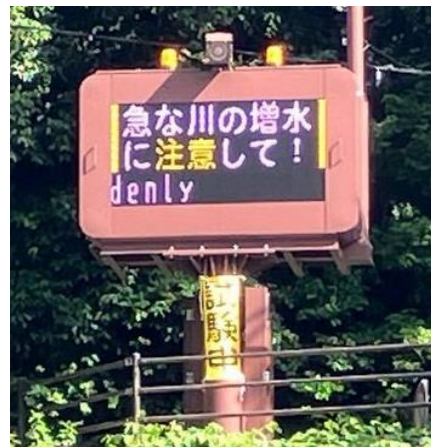
雨量情報表示盤の現地写真例
