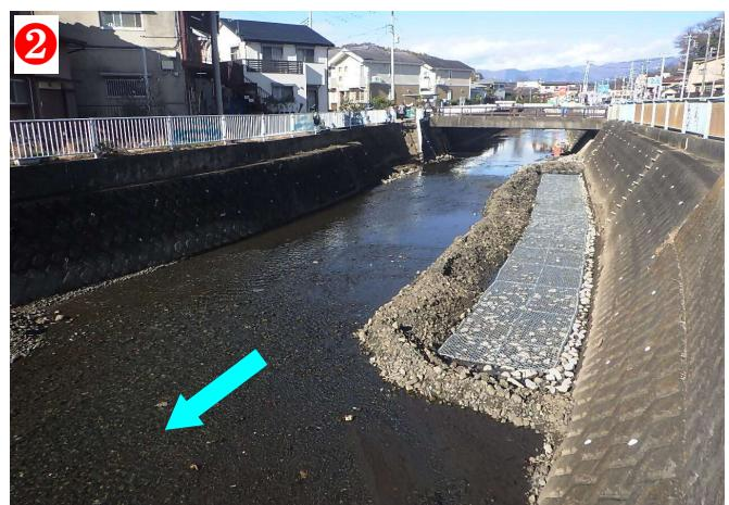
河川の水が入らないように土砂で締め切りを行い、根固工を据え付けている状況
