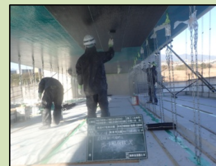
炭素繊維シート工
