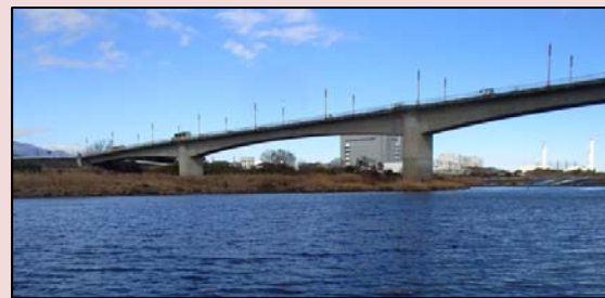
神川橋（寒川町側から上流を望む）
