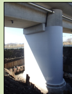
橋脚巻立て工
