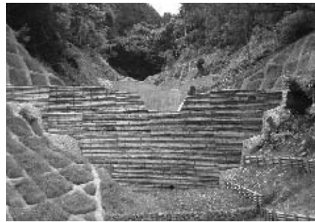
間伐材を使った谷止工（串川地域）
