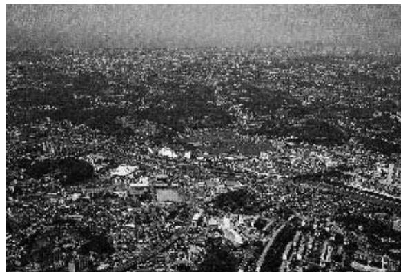
横浜湘南道路建設予定地 栄インターチェンジ・ジャンクション(仮称)付近
