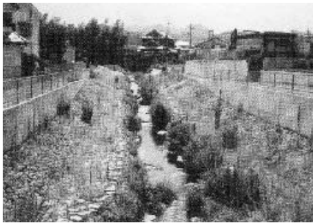
境川多自然型護岸整備
