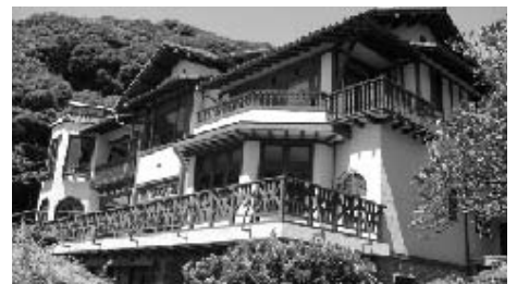
鎌倉文学館 (近代建築物の保全・活用)
