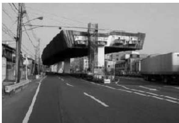
川崎縦貫道路（首都高速道路公団提供）
