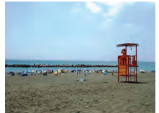
平塚海岸の離岸堤
