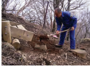
かながわパークレンジャーによる登山道の補修
