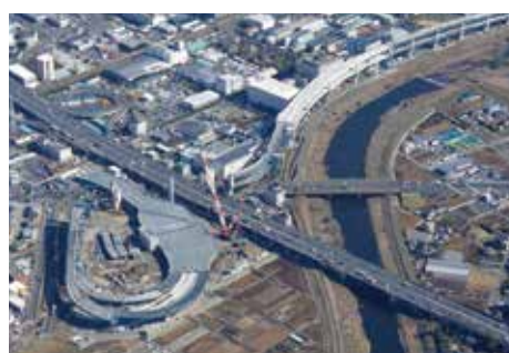
高速横浜環状北線 港北JCT
