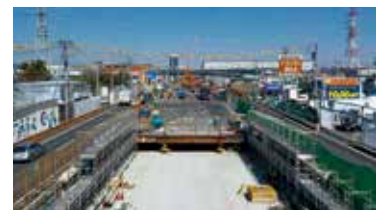
国道129号(戸田立体)の整備
