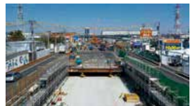
国道129号(戸田立体)の整備
