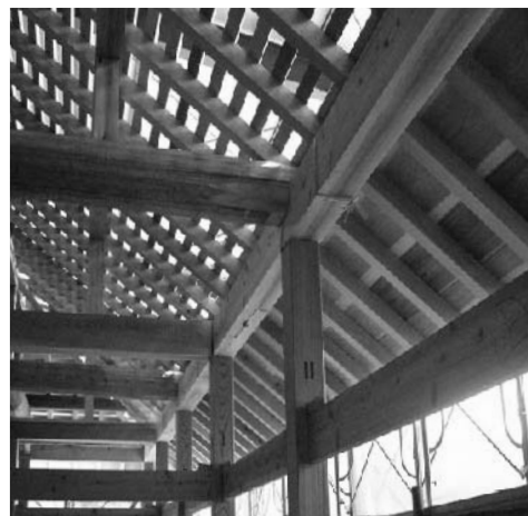
県産木材を使用した箱根関所の復元工事
