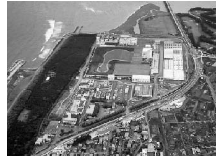
下水道整備の推進 （相模川流域下水道左岸処理場）
