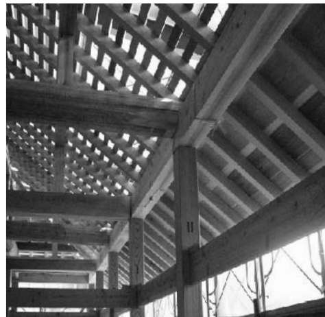
県産木材を使用した箱根関所の復元工事
