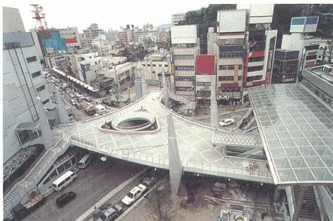
エレベーター付歩行者連絡橋(横須賀中央駅前広場(中央Yデッキ))
