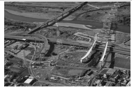
建設中の新東名高速道路
