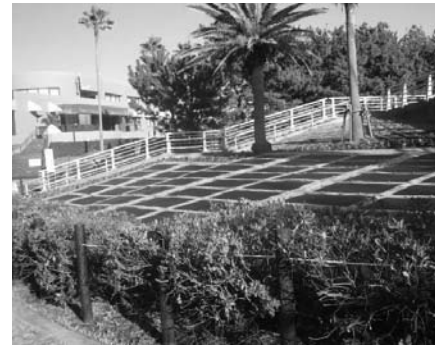
道路法面に設置した薄膜太陽電池
